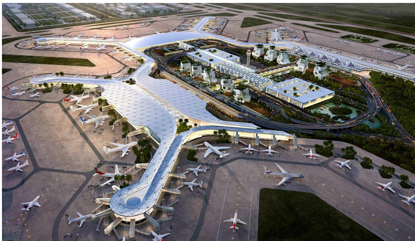
美兰机场 T2 航站楼即将完成钢结构屋盖提升
