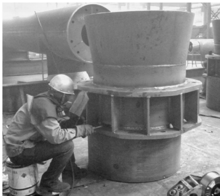
图 6 柱底板与钢管柱施焊
