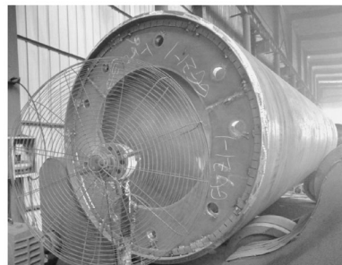
图 8 内隔板与钢管焊接
