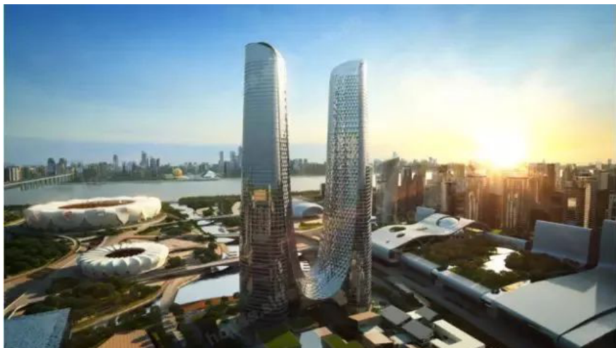
杭萧钢构助力杭州世界级新名片——“杭州之门”全民期待
