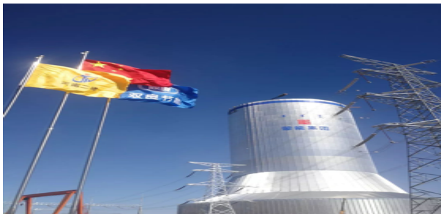
蒙能锡林热电厂全钢结构冷却塔落成
