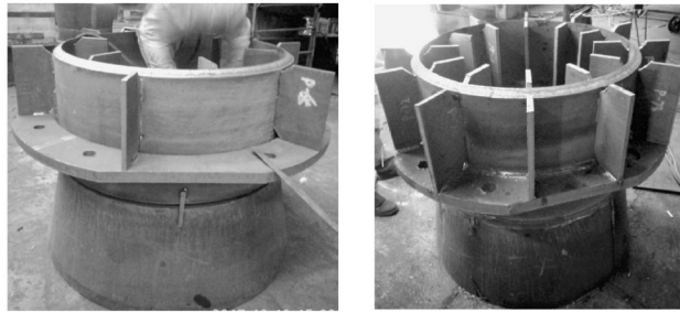
图 5 上层底板/内环板与钢管装配
