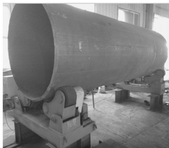
图 7 内隔板与钢管装配
