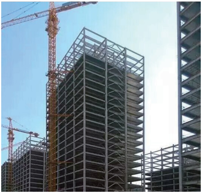
宁港财富中心 2-3# 楼钢结构工程顺利封顶
