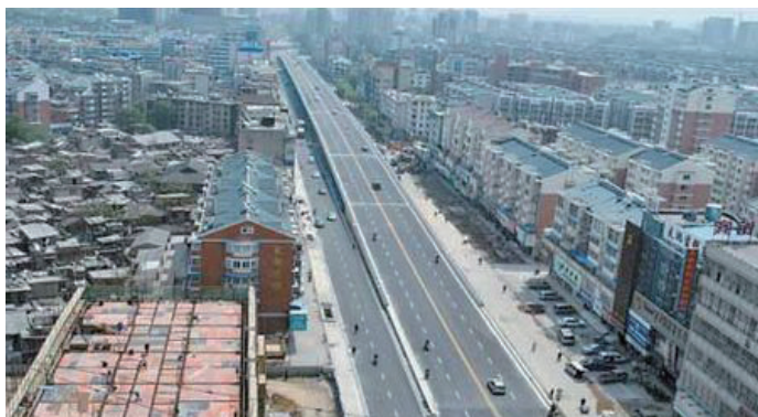
安徽省首个“钢结构”保障房即将在蚌埠开工
