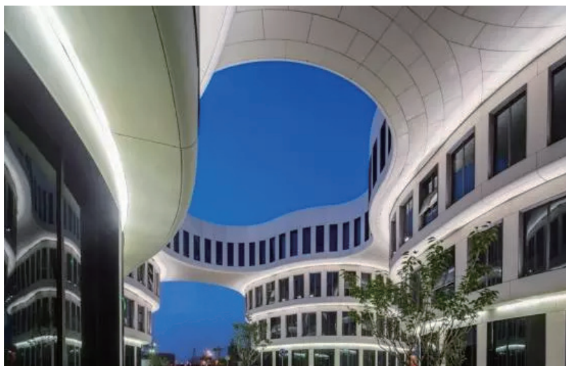
上海虹桥机场办公园区首座建筑“花瓣楼”完工验收
