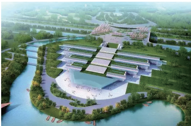
中建钢构打造的武汉园博会主场馆喜迎游客
