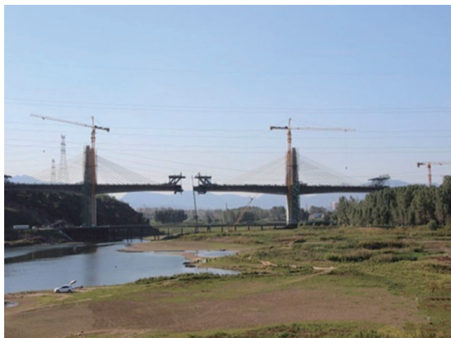
世界最大跨度波形钢腹板部分斜拉桥合龙
