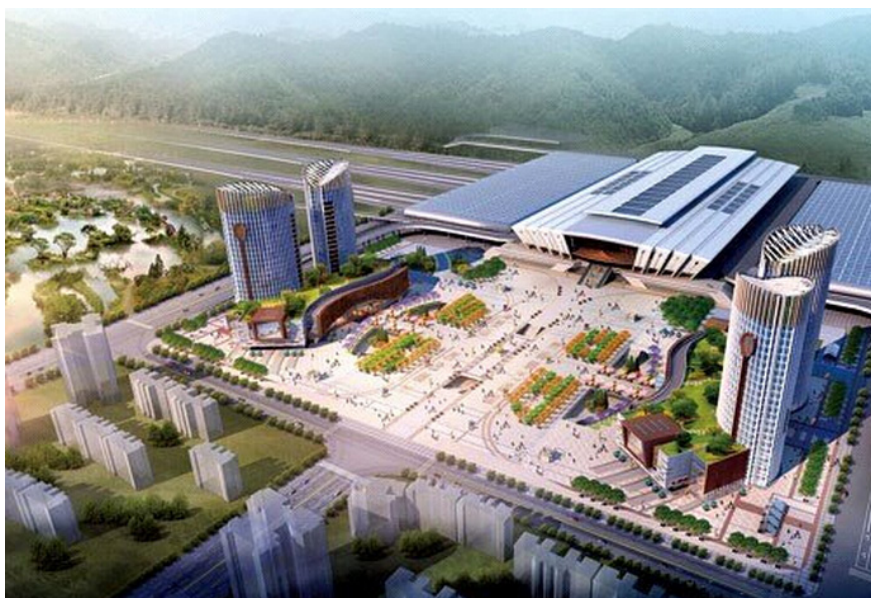
我国西南地区最大综合交通枢纽 昆明新南站主体工程完工
