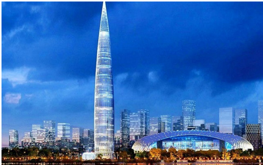
中建三局承建的深圳华润总部大楼封顶
