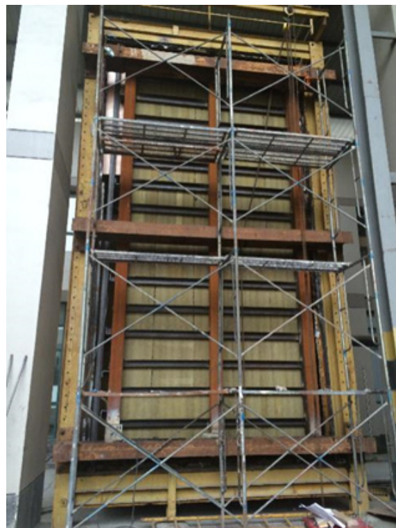
图 13 安装完成的试件
