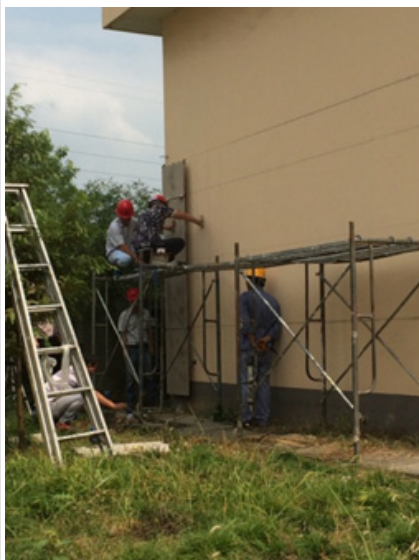
图 10 一体化板安装
