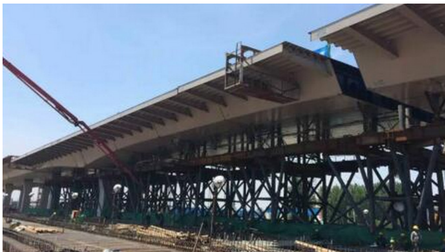
烟台首个纯钢结构高层建筑在高新区搭建 住宅钢结构年内破题
