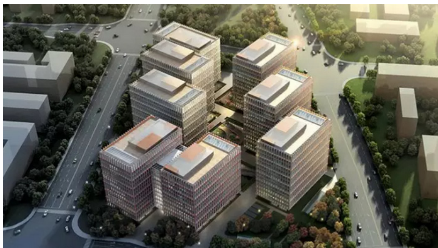
中通钢构中标北京小米移动互联网产业园项目钢结构工程
