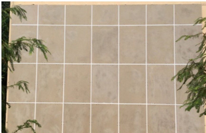
图 11 安装完成的一体化板
