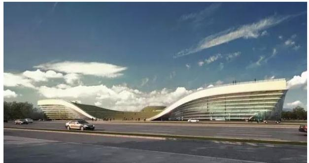
整个曲面屋顶被切割成无数阶梯, 每一级阶梯上表面为花岗岩石材, 侧面嵌植绿化条带。放眼望去, 屋顶广场是无边无际的草原还是茫茫戈壁滩, 取决于视线的角度。因此屋顶广场成为一个不断变化的梦幻之地: 从草原到戈壁滩。每隔 5 级台阶, 就有一条曲线成为屋顶天窗, 为室内空间带来充足阳光。
