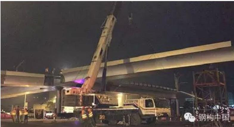
“从本月20日, 开始进行天桥主梁的吊装, 用时一周吊装完。”孙久文告诉记者, 近年来, 我市启动建设的约20座天桥, 全部采用钢结构形式。这种箱型钢结构人行天桥的主要材质为特种钢, 具有耐压、耐磨、抗腐蚀等功能。制造后以分段的形式出厂, 然后通过现场拼接、整体吊装来完成。
