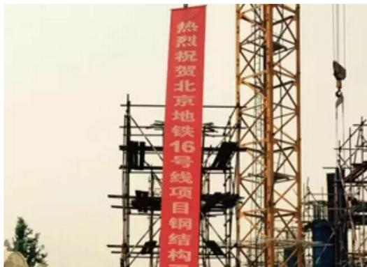
7月7日, 由中建钢构有限公司承建的北京地铁 16 号线钢结构工程顺利开吊。本工程位于北京市海淀区北清路北安河, 钢结构范围包括咽喉区、运用库。总建筑面积约 45 万 $m^2$ , 高度 30m, 地上 9 层, 地下 3 层。结构形式为劲性框架结构, 主要构件为: 十字型、H 型、圆管型、组合型和钢板墙, 用钢量约 2 万吨, 工期紧、任务重, 预计于 2016 年 9 月正式通车。
