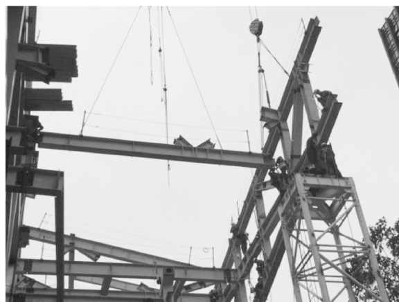
图 8 桁架吊装就位同时伸臂梁安装
