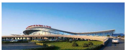
通用建筑中标贝宁新国际机场项目航站楼钢结构工程
