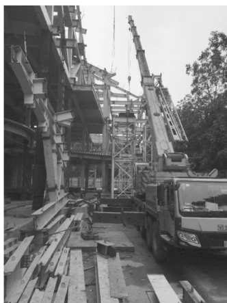
图 7 汽车吊吊装格构式胎架
