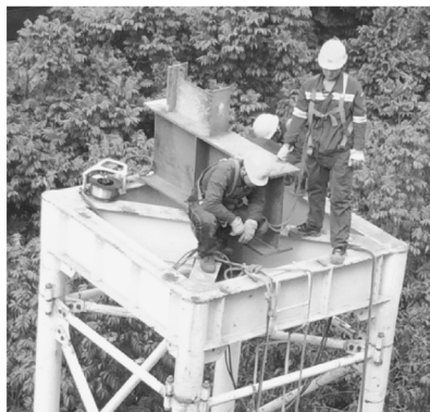
图 6 胎架支撑点开槽设计
