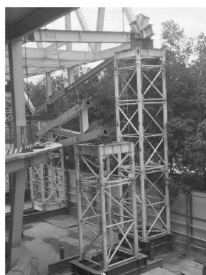
图 9 上下伸臂悬挑桁架倒退式安装
