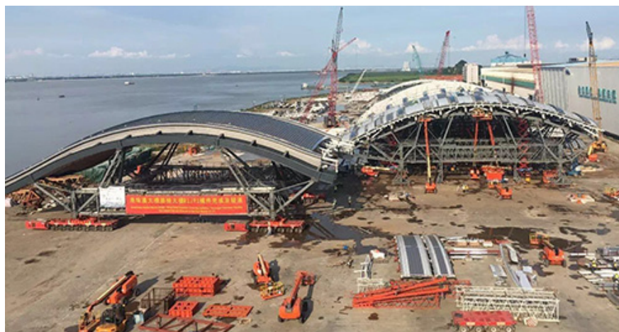
精工国际承建的香港旅检大楼工程首个模块转运装船顺利完成
