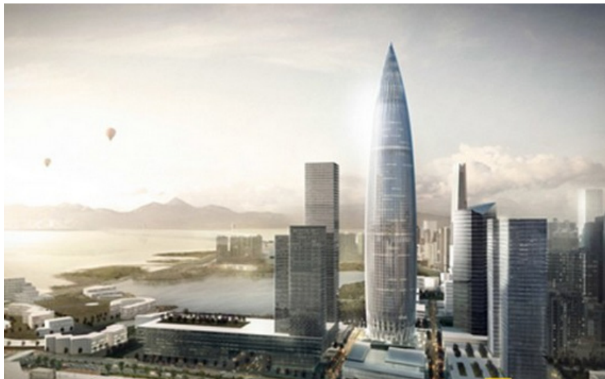
华润总部大厦外框钢结构突破 300 米大关
