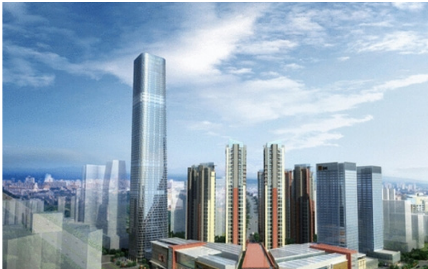
广西 445 米“第一高楼”地上钢结构顺利开吊
