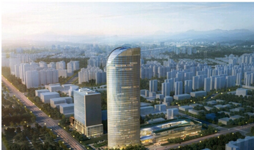
杭萧钢构延长石油研发中心项目塔楼结构顺利封顶
