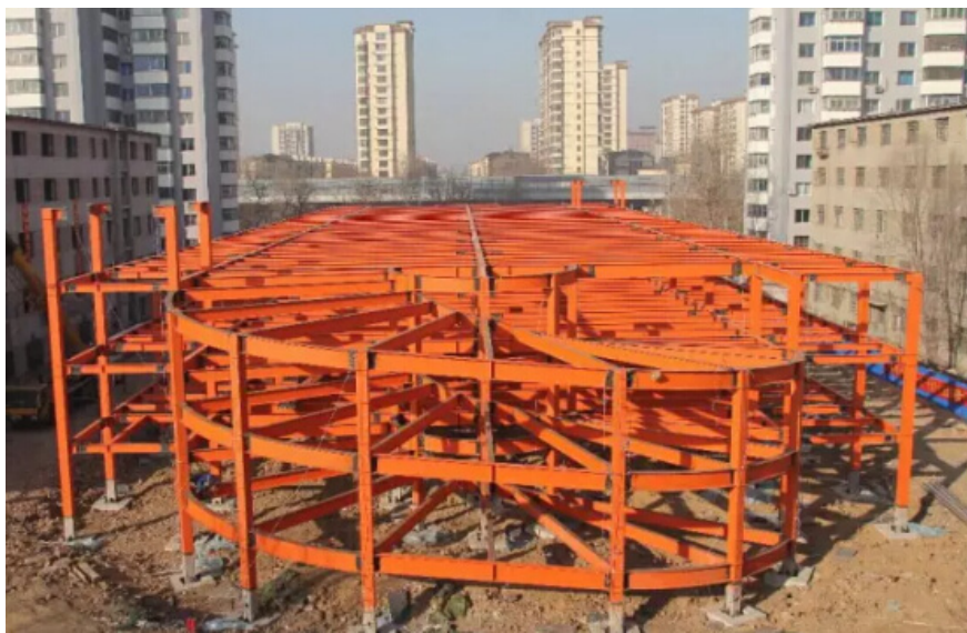
辽宁省第一座钢结构自走式立体停车场即将交付使用
