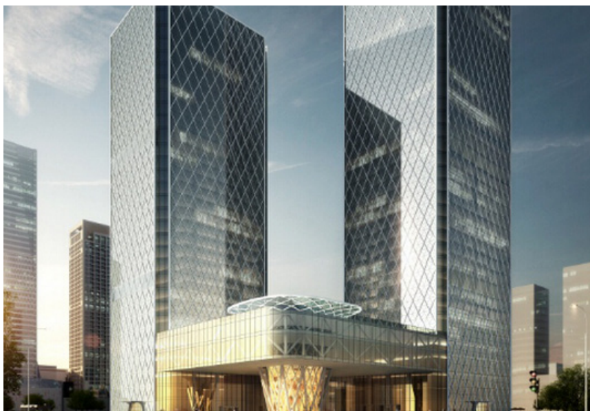
中通钢构中标济南历下区金融中心钢结构工程
